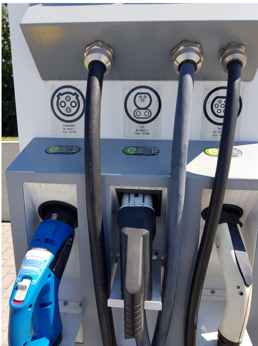
Figura 2– Dispositivo di ricarica con connettore multistandard (CHAdeMO, CCS, Type 2) finanziato dall’MCE
